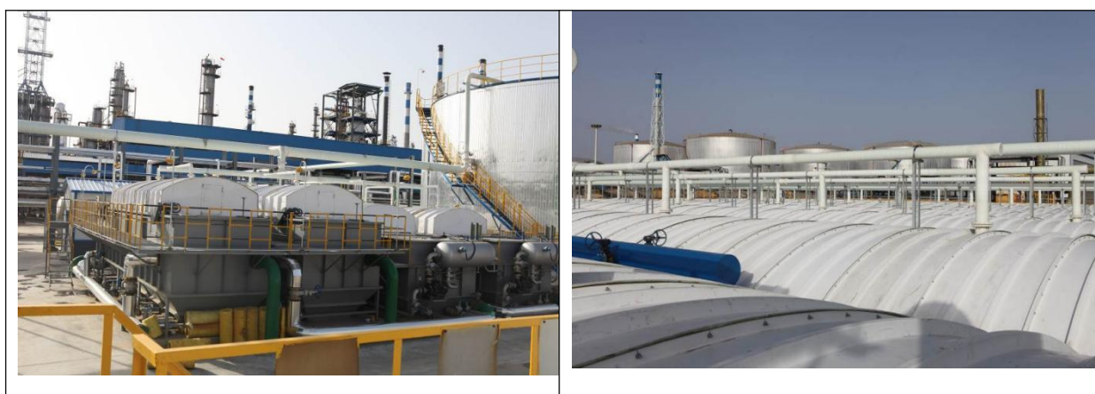
图4.1-1 厂区现有200t/h污水处理站
