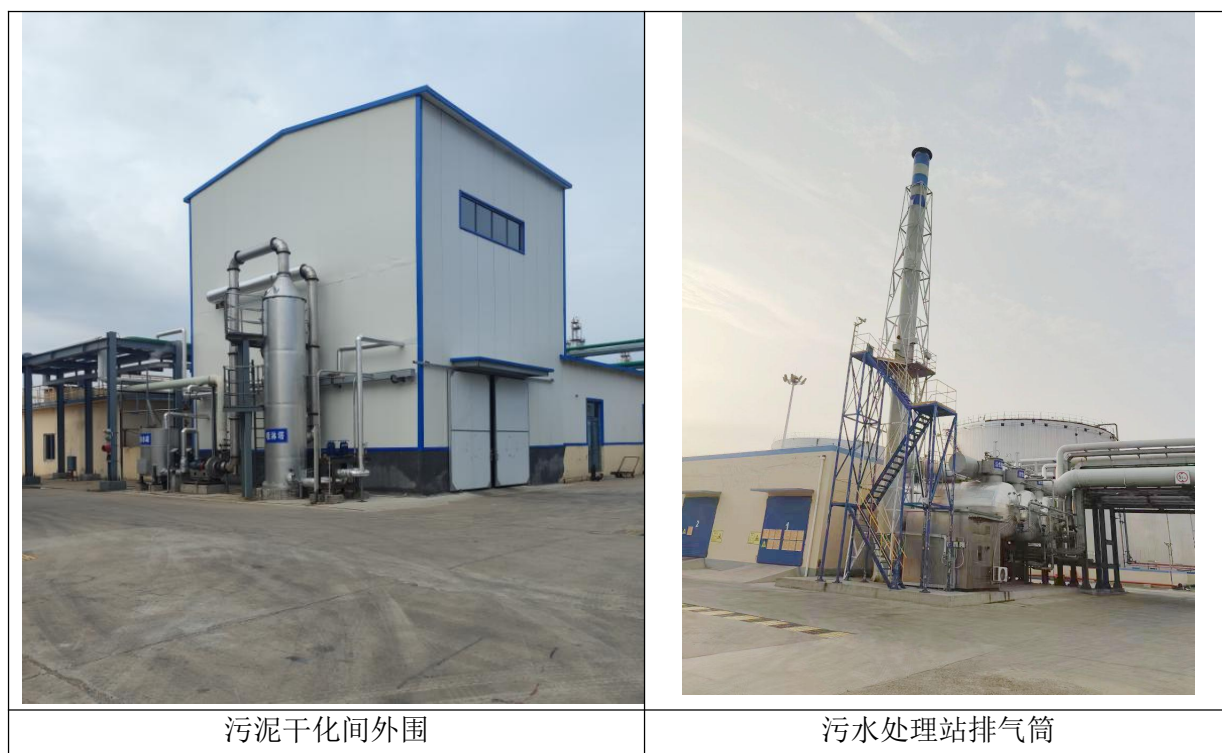
图 3.3-1 项目建设现状图
